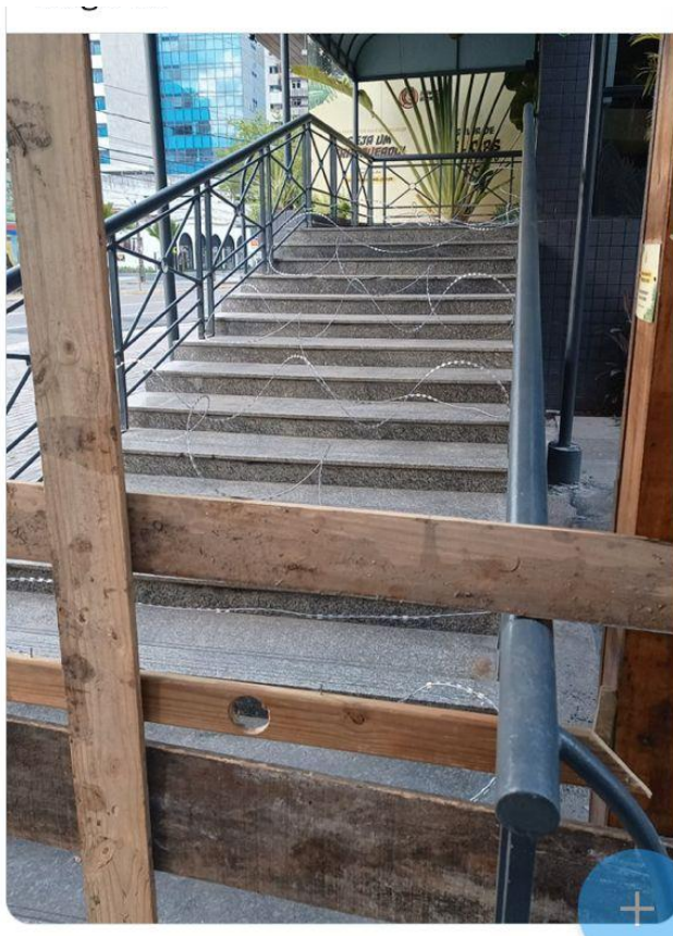
Escadaria do imóvel situado na Rua Ernesto de Paula Santos, nº280 (antigo Restaurante Mundo Animal), no bairro de Boa Viagem.
