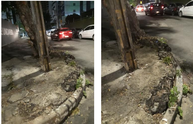
Foto Rua Real da Torre, Torre, Recife.
